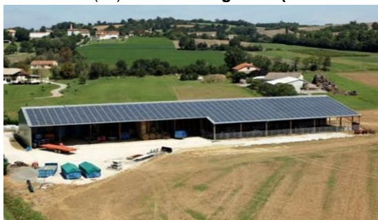
BARON Montoussin (31) - Bâtiment agricole (neuf et rénov.)
