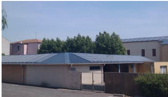
GRUPE SCOLAIRE HENRI BARBUSSE Saint-Martin-de-Valgalmes (30) - Ecole (rénovation)
