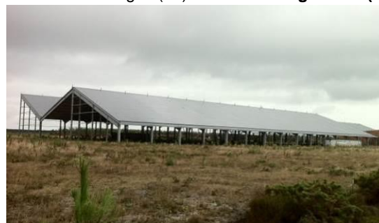
SOLAR MIMIZAN Pontenx-les-Forges (40) - Bâtiments agricoles (neuf)
