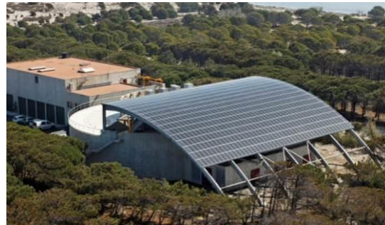
STATION D'ÉPURATION DE LEUCATE Leucate (11) - Brise-soleil (neuf)
