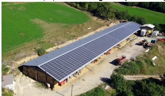
LE REYNARD La Rochette (05) - Bâtiment agricole (rénovation)
